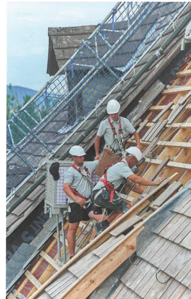
Die Dachdecker arbeiteten wegen des hohen Gewichts der Platten zusätzlich mit einer PSAG.
