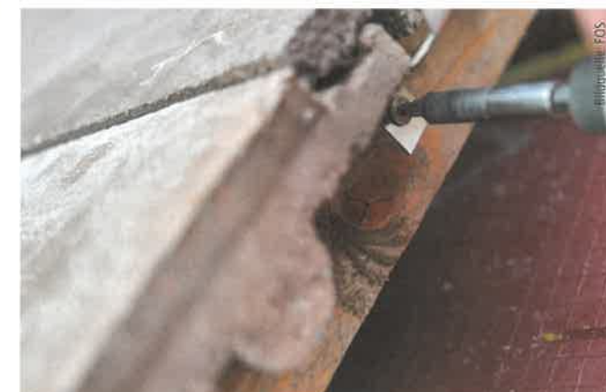
Die Klammer wird auf der Traglatte verschraubt.
