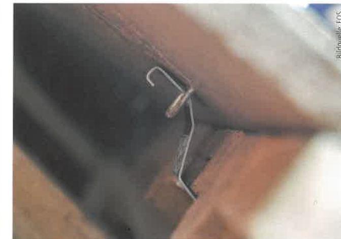
Die Öse ist in die Dachplatte eingearbeitet.
