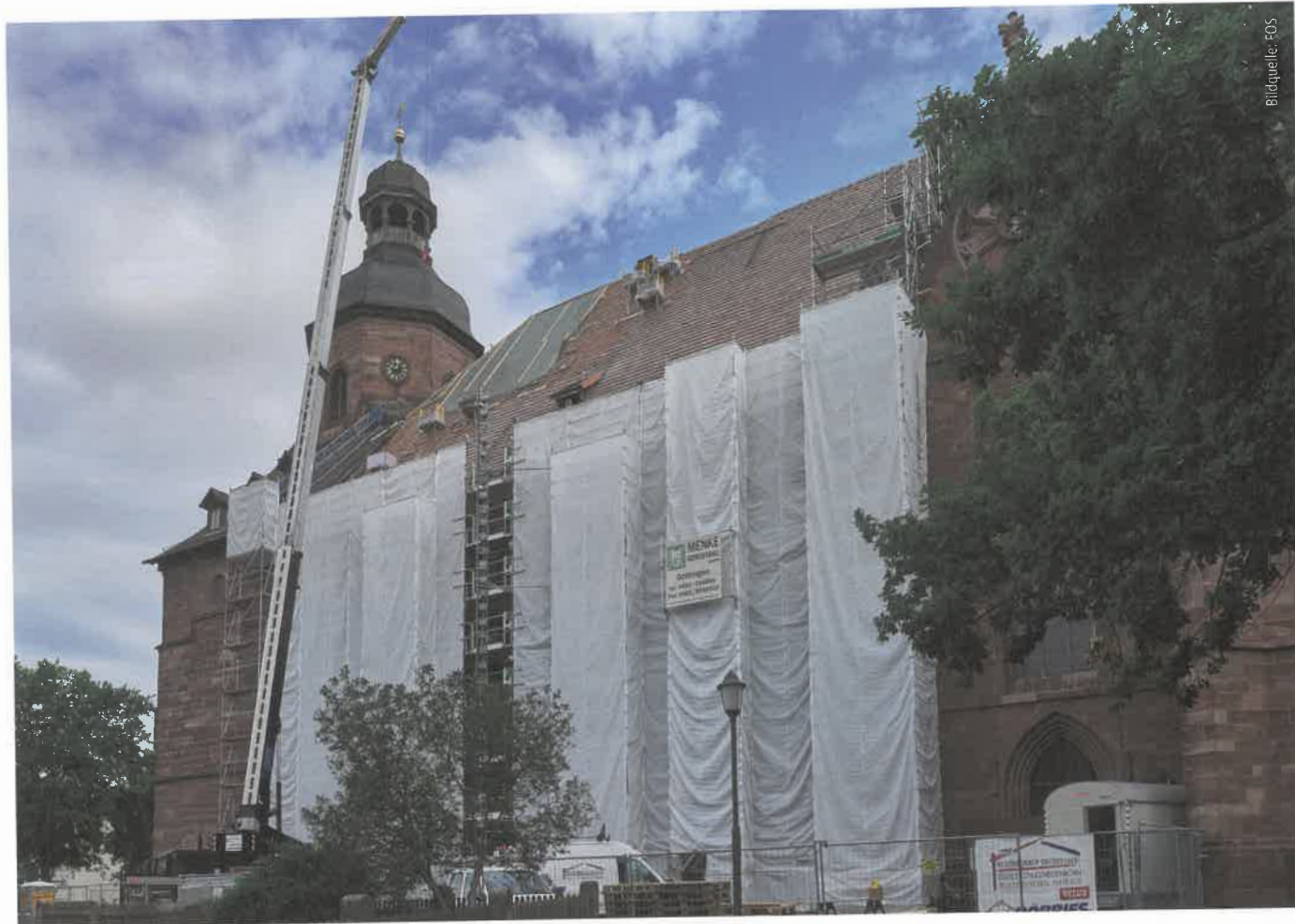
Wegen Unwetterwarnungen waren weitere Sicherungsmaßnahmen nötig.
