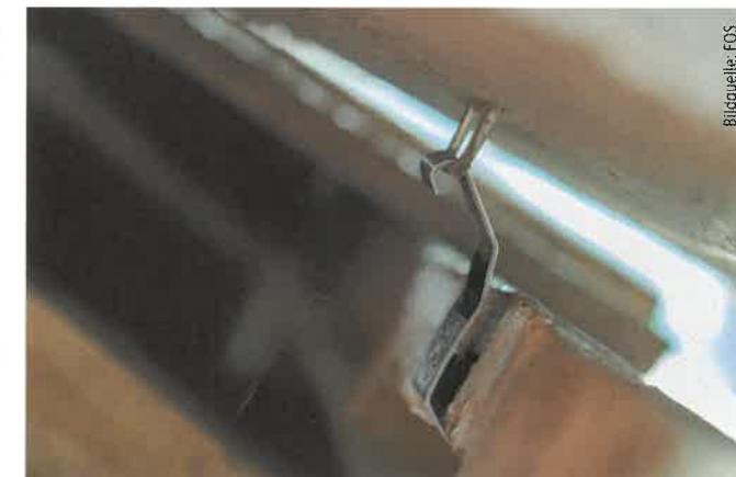
Der Haken wird eingefädelt, die Platte heruntergezogen.
