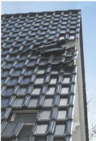
▲ Typischer Sturmschaden am Ortgang eines Satteldachs
