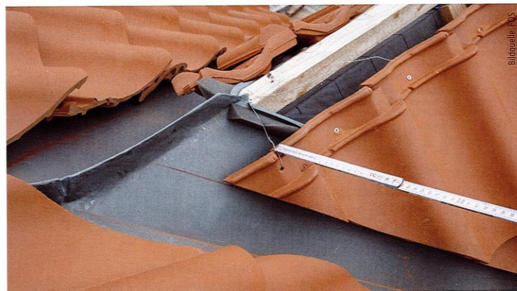
Durch die vielen Teilflächen waren viele Ziegel zuzuschneiden. Das Ergebnis ist ein harmonisch gedecktes Dach. Details wie Kehlen oder Anschlüsse zu aufgehenden Gebäudeteilen brauchen nicht nur individuelle Beachtung, sondern auch ihre Zeit. Der Detail-Blick zeigt, wie aufwändig die Zuschnitte auszuführen waren. Auch die Sturmsicherung der Zuschnitte war exakt auszuführen. In der Kehle wurde die Sturmsicherung in einem Schrauben/Draht-Mix vorgenommen.
