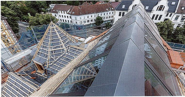
Das Dachlicht wurde dem Denkmalschutz gerecht angefertigt.
