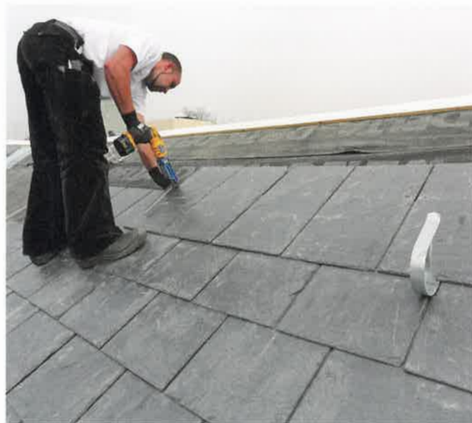
Ästhetisch und robust zugleich: Klassische Schiefer-Rechteck-Doppeldeckungen stehen für geradlinige Dachflächen. Rathscheck
