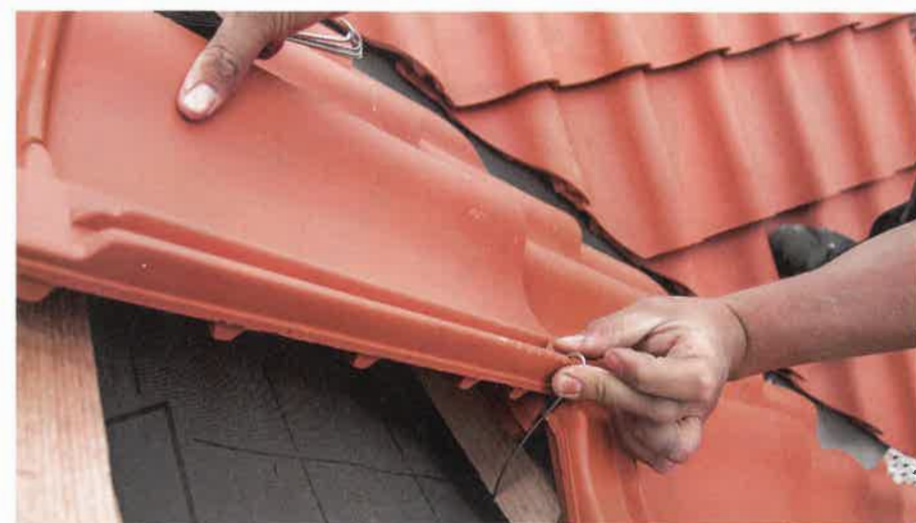
Eine fachgerecht ausgeführte Windsogsicherung mit witterungsbeständigen Sturmklammern aus Metall steigert den Versicherungsschutz, den Immobilienwert und die Sicherheit. FOS
