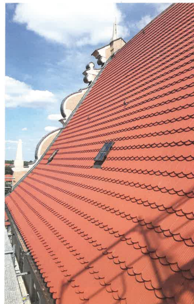
▲ Die roten Biberschwanzziegel bieten in der Kronendeckung ein edles Deckbild. Der Anschluss an das Mauerwerk erfolgte ebenfalls mit Bleiblech
