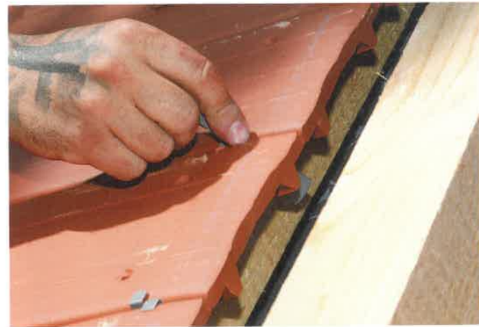
▲ Werkzeuglose Verlegung: Die Sturmklammer wird einfach zwischen zwei Biberschwanzziegel gesteckt und schließt darunter an der Traglatte an
