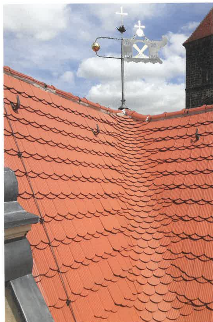
▲ Kunstwerk Biberkehle: Die eingebundenen, ungleichhüftigen Kehlen sind drei Ziegel breit und ergeben hier ein schönes, gleichmäßiges Deckbild
