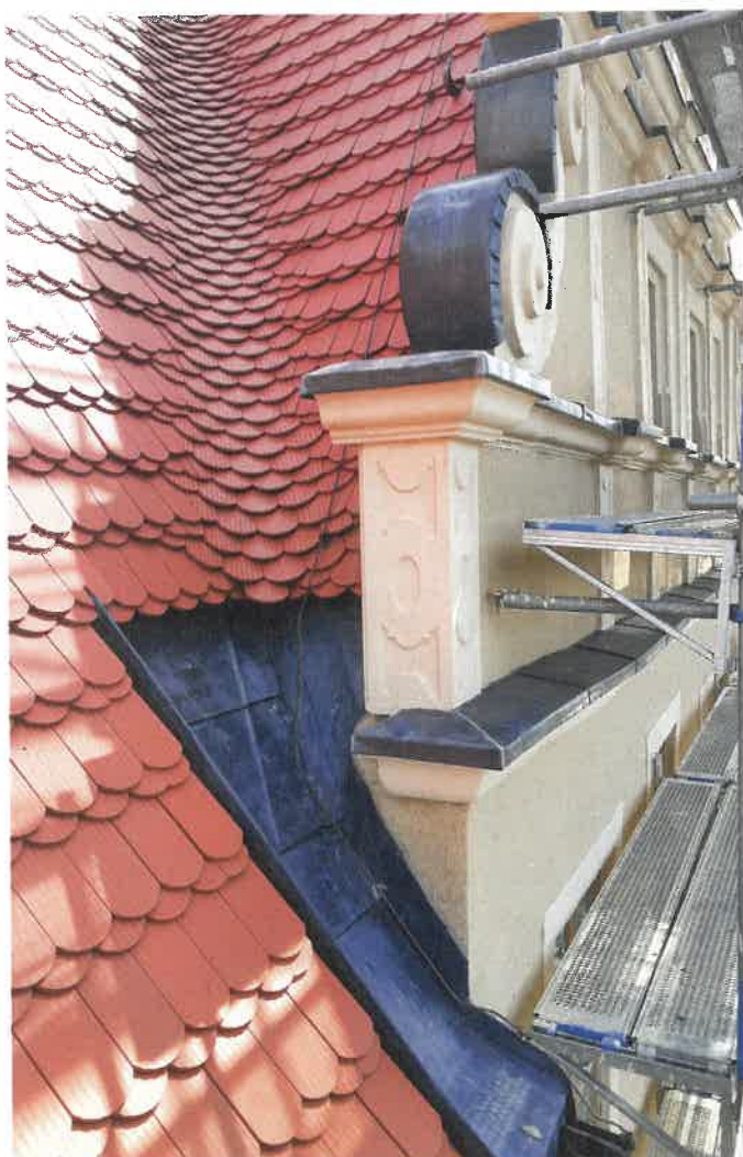
▲ Kunstwerk Biberkehle: Die eingebundenen, ungleichhüftigen Kehlen sind drei Ziegel breit und ergeben hier ein schönes, gleichmäßiges Deckbild
