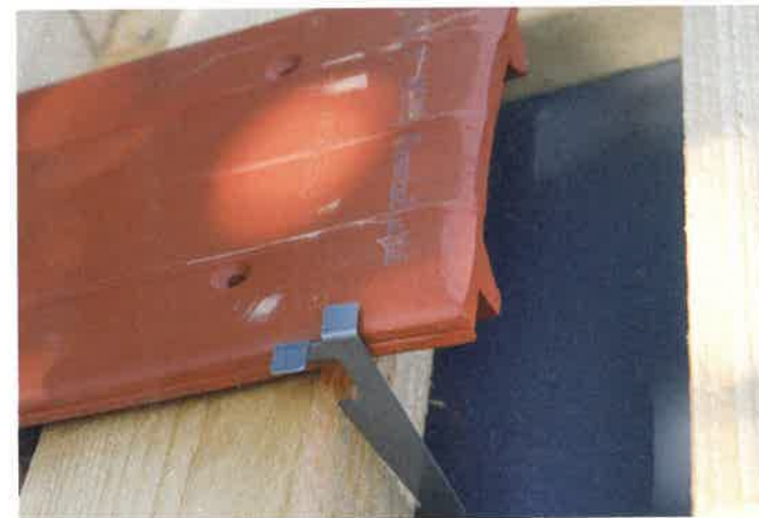
▲ Das Prinzip: Eine Klammer verankert je zwei benachbarte Ziegel an der Dachlatte. Die Klammer muss dafür auf Biber und Lattung abgestimmt sein
