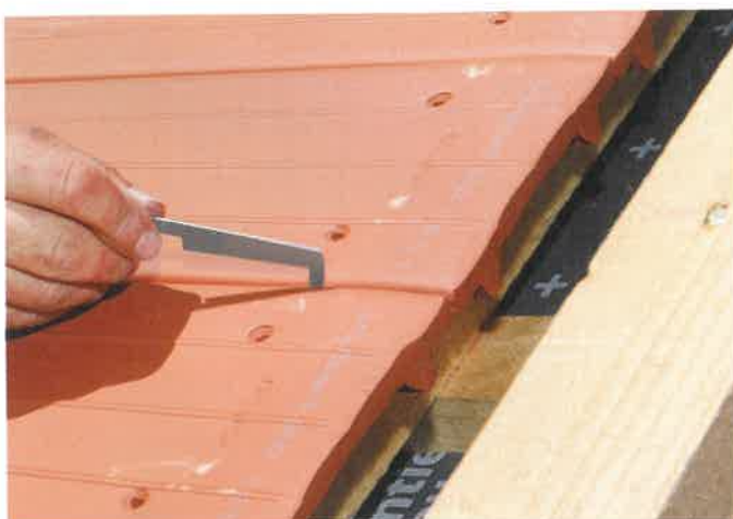
▲ Werkzeuglose Verlegung: Die Sturmklammer wird einfach zwischen zwei Biberschwanzziegel gesteckt und schließt darunter an der Traglatte an
