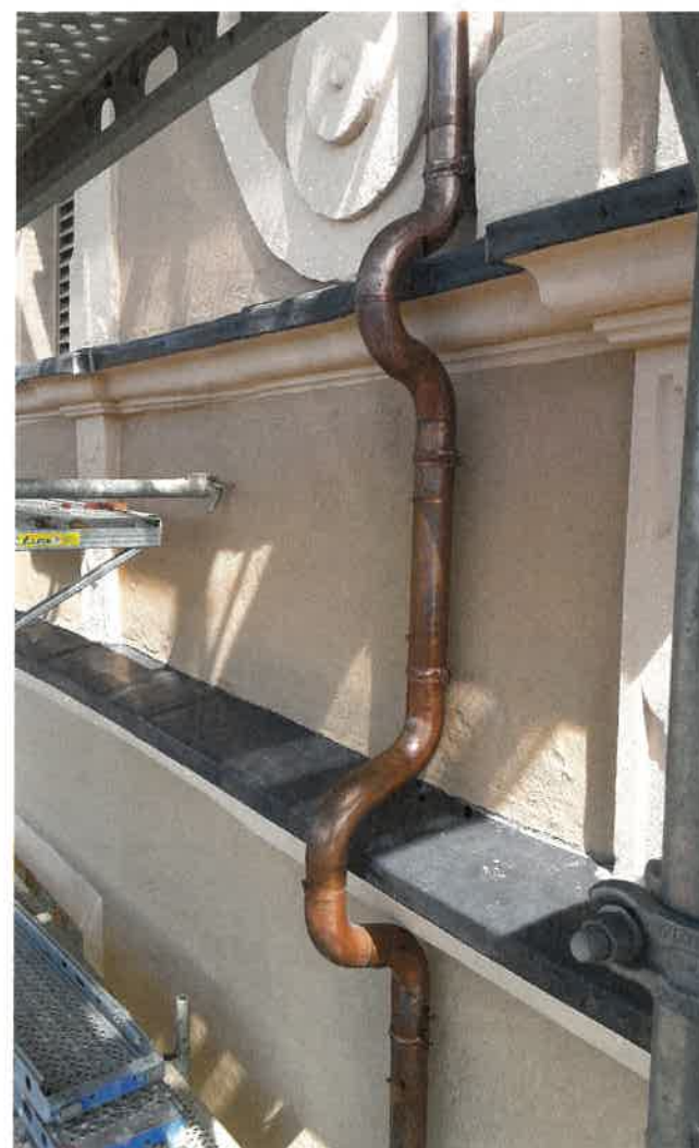
▲ Metalldetails: Die Mauerabdeckungen wurden mit Walzblei ausgeführt
