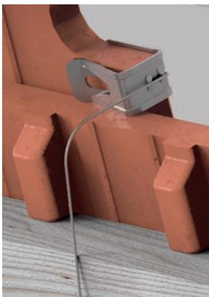
Die Montagehilfe 513 wird einfach auf den geschnittenen Biberschwanzziegel am Grat aufgeschlagen und der Draht an der Unterkonstruktion befestigt.
